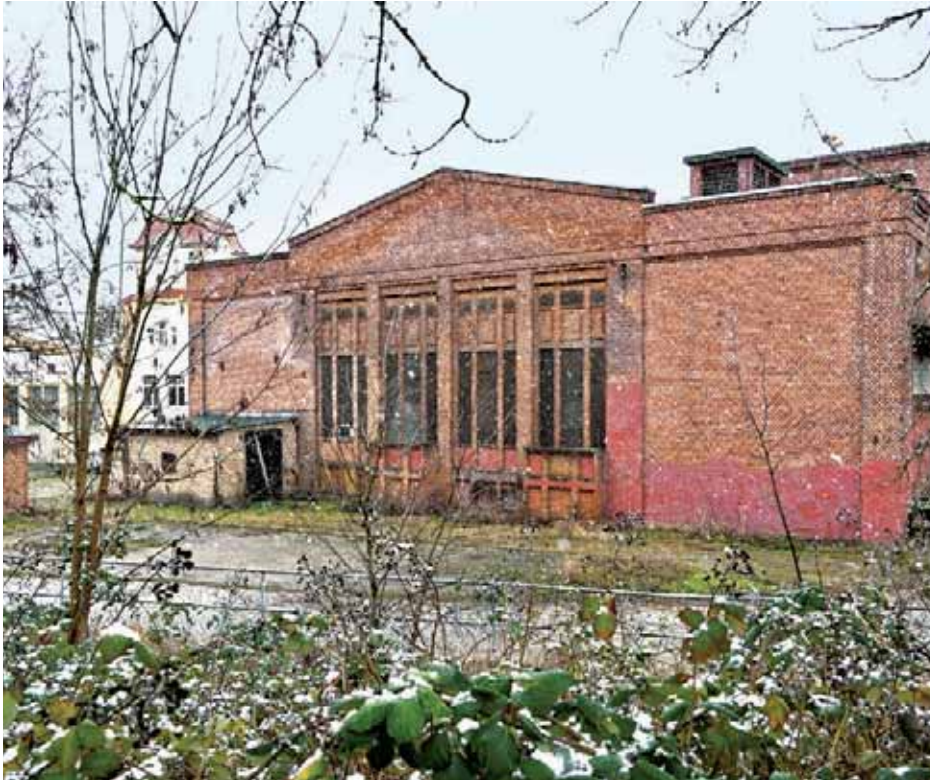
Die Halle des ehemaligen E-Werks in Brandenburg an der Havel, in die die Zahnklinik einziehen soll
